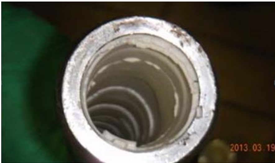
Interno della tubazione completamente pulito grazie all'azione di AquaRing®
