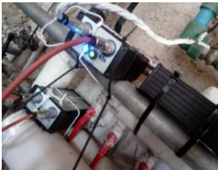
Installazione unità AquaRing® contro il calcare e contro i batteri.
